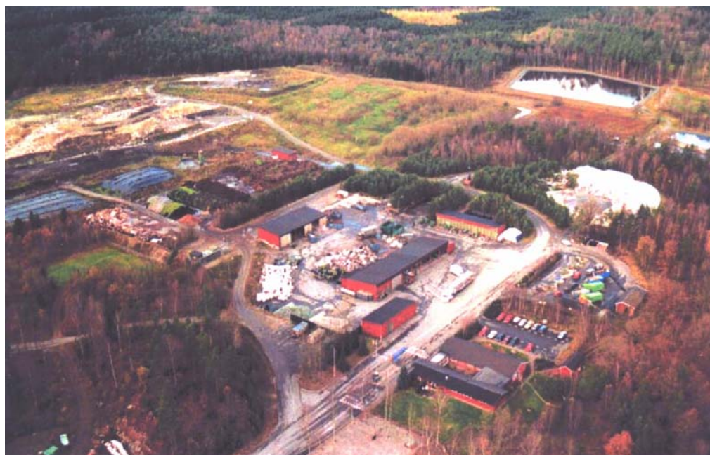
Figur 1. Flygfoto över Vankiva avfallsanläggning.
